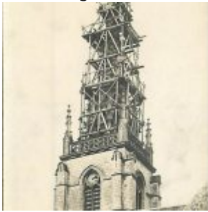
Réfection de la flèche en 1929
